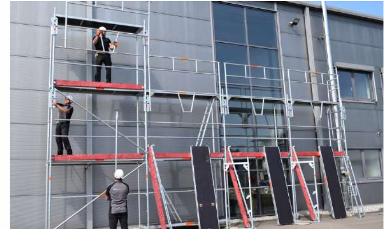
Bild 1 - Beispiel vertikaler Handtransport von Gerüstbauteilen
